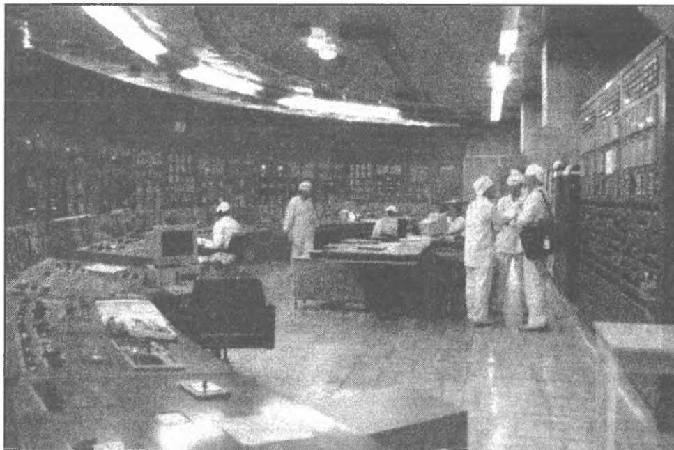
Чорнобильська атомна станція. Фото: Таня Д'Авіньон.
